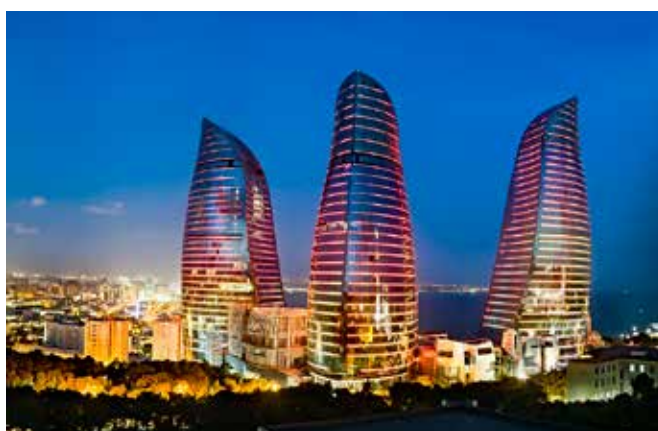
Flame Towers - Азербайджан - Mini Canal
