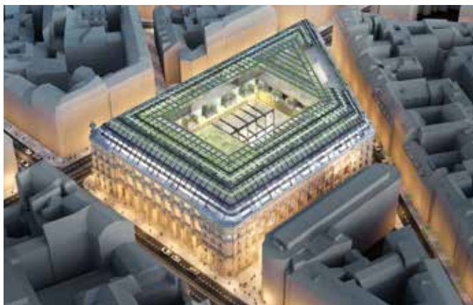
Poste du Louvre - Франция - Clima Canal
